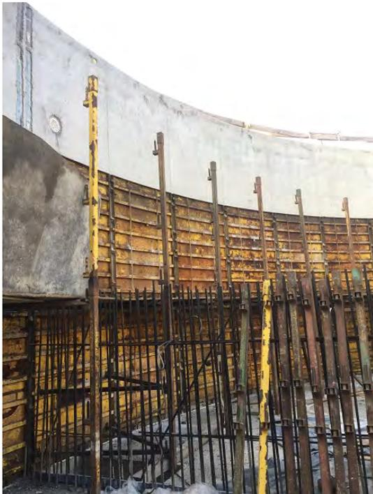
Hier wird das demontieren der Schalung gezeigt. Man sieht auch schon die fertige Wand. Diese wurde noch mit Nachbehandlungsmittel zur langsameren Austrocknung besprüht.
