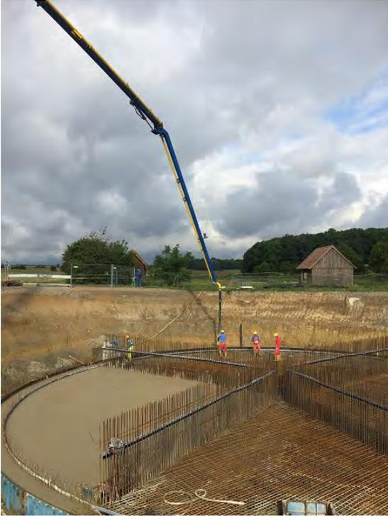
Die Bodenplatte wurde am 06. September betoniert. Hier flossen 300 m<sup>3</sup> Beton hinein. Die Aktion hat morgens um 7 Uhr begonnen und war um 15 Uhr abgeschlossen.
