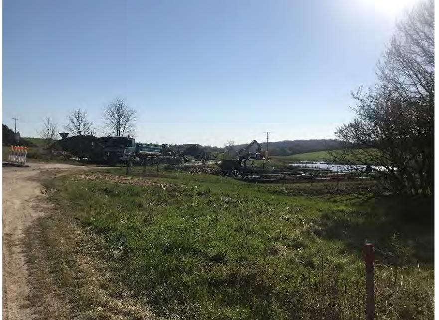
Baugrube für die Pumpstation Habelsee. Diese ist etwa 4 Meter tief. Das angrenzende, schon vorhandene Vorklärbecken wird umgebaut, um die Funktion eines Stauraumkanals zu erfüllen.
